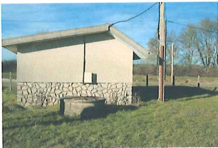
Le puits à l'arrière du bâtiment de captage
